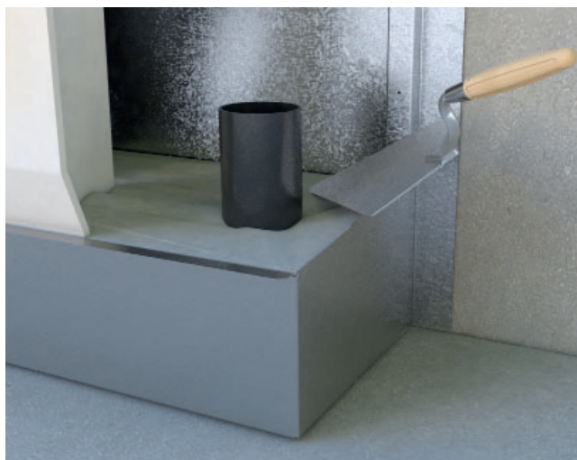
Schaktbotten formas med fall
