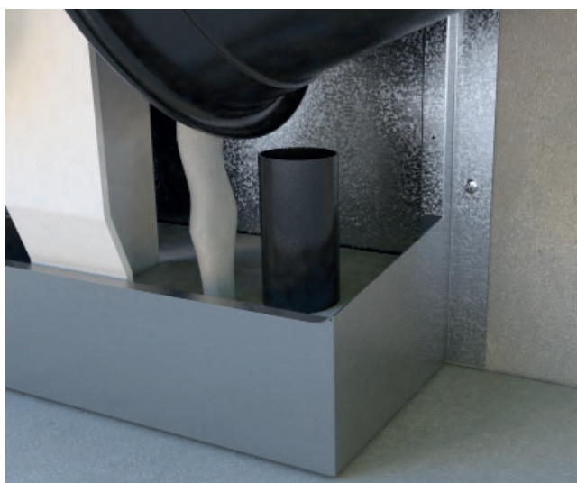
Schaktbotten och håltagning gjuts igen
